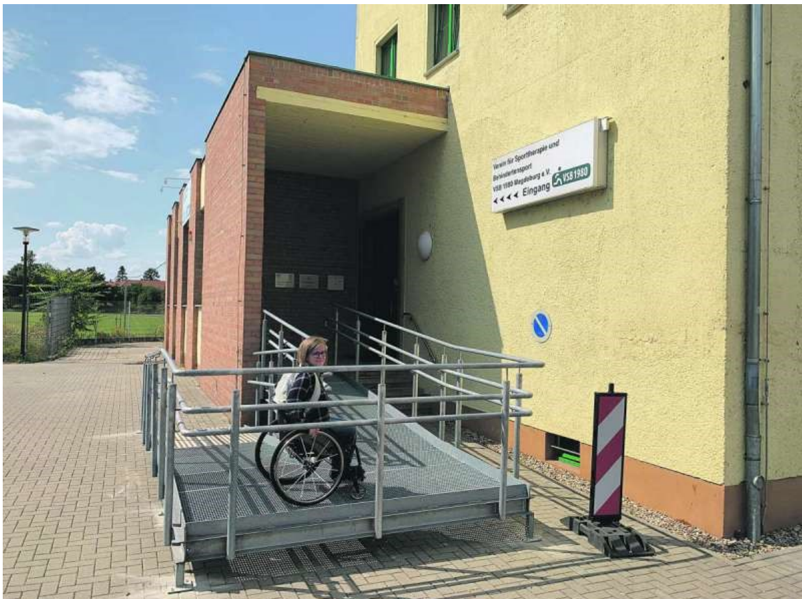
Rollstuhlrampe wurde zum Haupteingang verlegt
